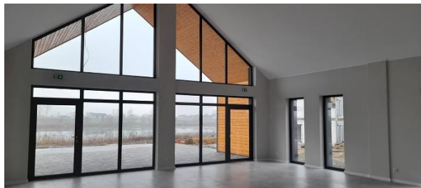
Gmina Chełmża Budowa świetlicy wiejskiej w miejscowości Strużal
