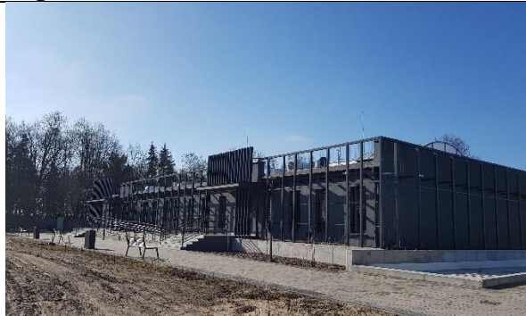
Gmina Łysomice Adaptacja budynku po dawnym magazynie na cele aktywizacji społecznej
