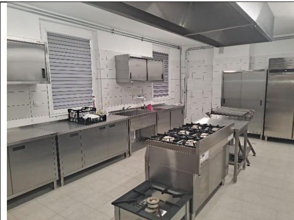
Gmina Papowo Biskupie Remont świetlicy wiejskiej w miejscowości Zegartowice
