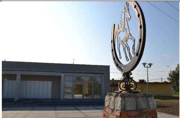
Gmina Chełmża Przebudowa świetlicy wiejskiej w Kończewicach
